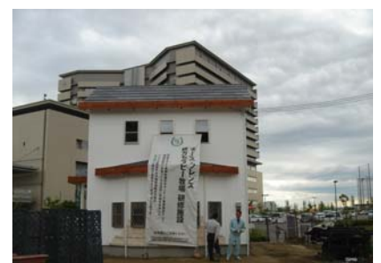
(株)匠建より寄贈の研修施設「癒しの家」です。お気軽にご利用ください。
